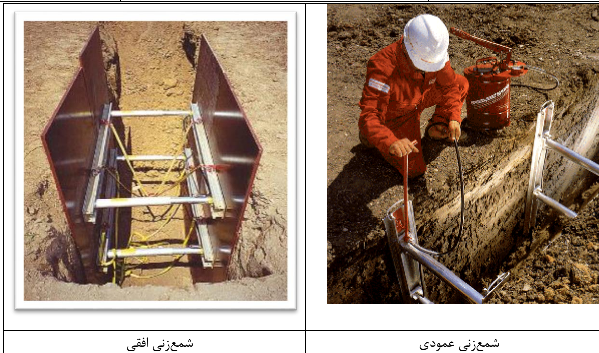
شکل ۴۳: شمع زنی افقی و عمودی
