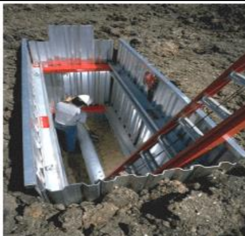
شکل ۷: نمونه‌ای از راه ورود و خروج به محل گودبرداری
