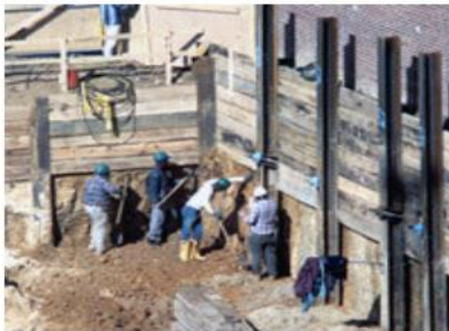
شکل ۱۱: نمونه‌ای از پایدار ساختن بنای مجاور گودبرداری
