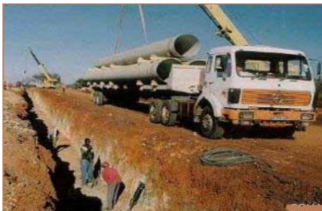
شکل ۸: نمونه ای از بارهای با پتانسیل سقوط
