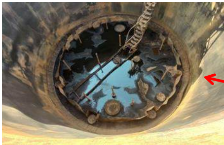
شکل ۳- وضعیت سقف شناور پس از آتش سوزی
