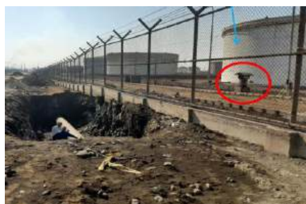
شکل ۱- نصب ترانس در فاصله ۱۰ متری خط
