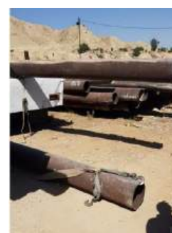
نحوه استفاده از تسمه یک متری با دو قلاب، جهت باربرداری دو لوله به طور همزمان
