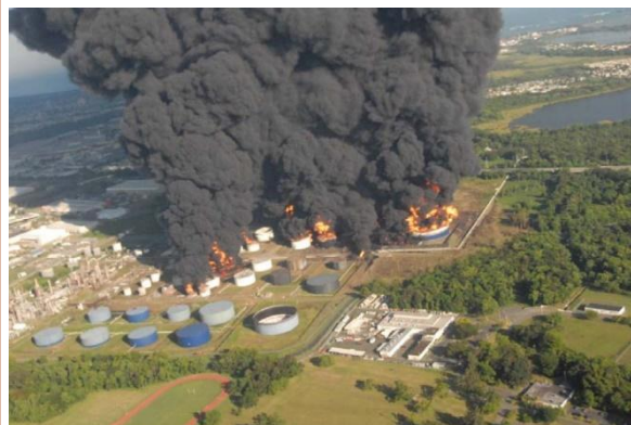
سوختن چندین مخزن در اثر حریق
